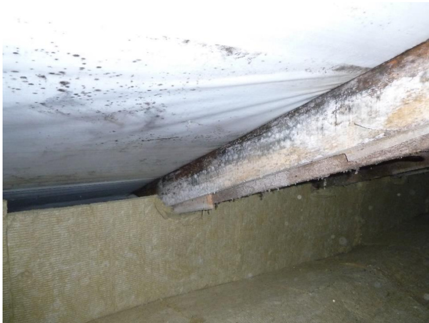
43 pav. Užsiveisę pelėsiniai grybai nevėdinamoje pastogėje modernizavus pastatą
