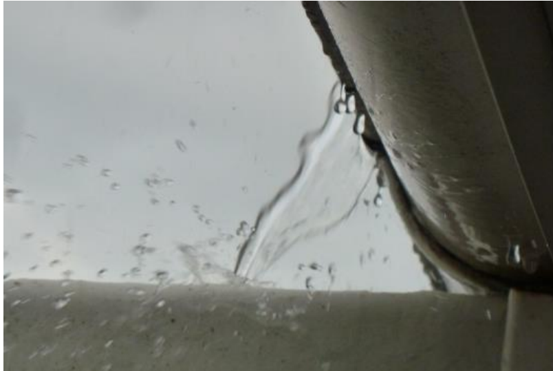
46 pav. Nuo stogo tekantis lietaus vanduo viš žemai įrengto latakų
