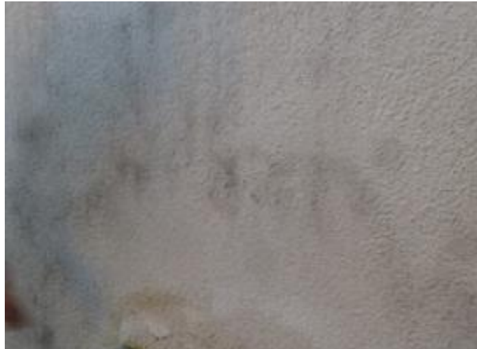
22 pav. Fasado dėmės dėl mikroorganizmų poveikio gausiai apželdintoje aplinkoje
