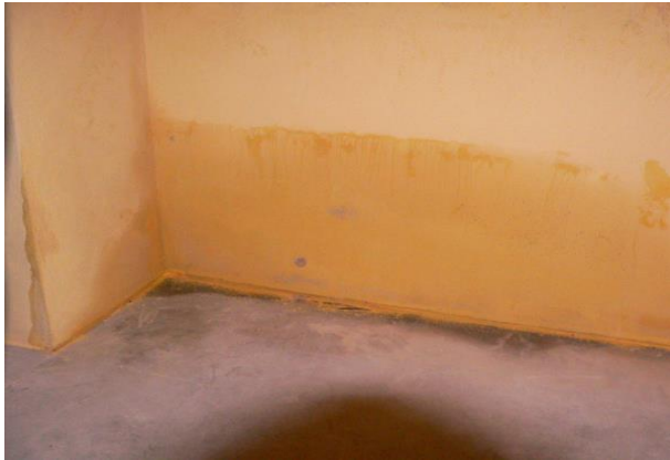
48. pav. Atitvaros gedimas, kai drėgmė iš drėgno grindų pagrindo šalinasi per grindų polietileno plėvelės pakraščius
