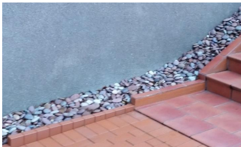
5 pav. Tinkuota cokolio apdaila, esanti prie vėdinamos ir drenuojamos nuogrindos po 20 metų.
