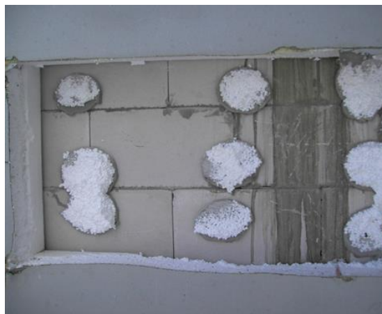
16 pav. Neteisingai priklijuotos šiltinimo plokštės fragmentas – plokštės nebuvo suteptos klijais visu plokščių perimetru
