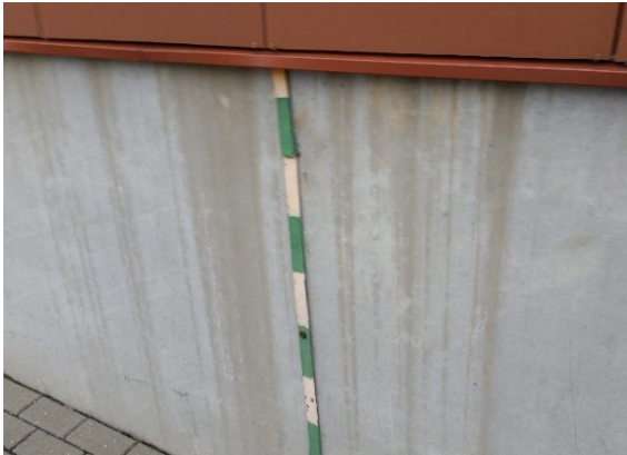
28 pav. Cokolio fragmentas, esantis žemiau vėdinamos šiltinimo sistemos su atviromis siūlėmis
