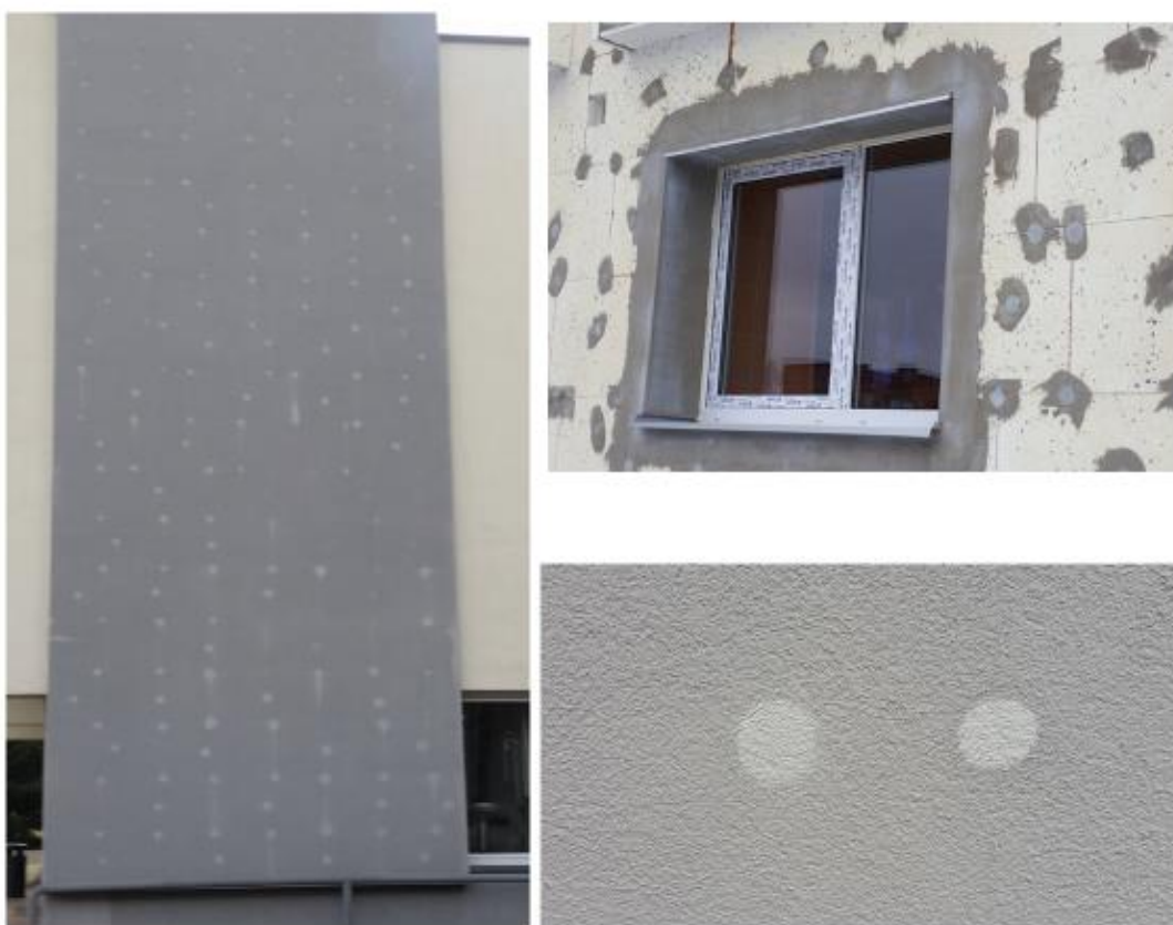
20 pav. Šiltinimo plokštės tvirtinimas sraigatine smeige
