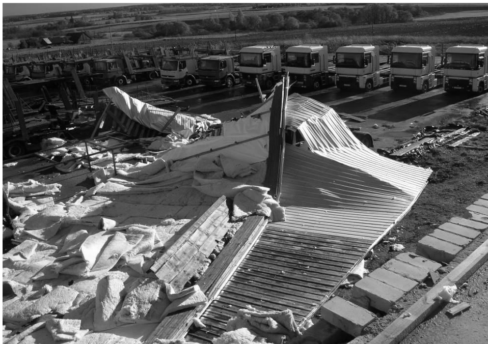
37 pav. Vėtros suardytas nepatikimai sutvirtintas šlaitinis stogas
