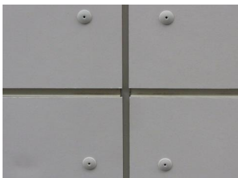
27 pav. Teisingai įrengtos vėdinamos termoizoliacinės sistemos (su dengtomis siūlėmis) fragmentas
