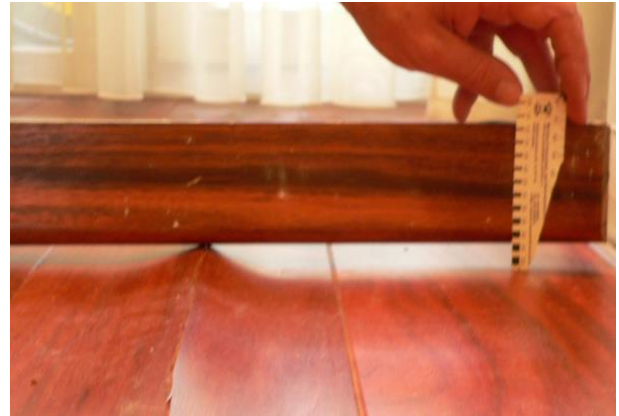
49 pav. Grindų dangos gedimas, kai drėgmė iš drėgno grindų pagrindo šalinasi per polietileno plėvelės siūle.
